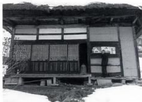
古坂の薬師堂 (修理前)
